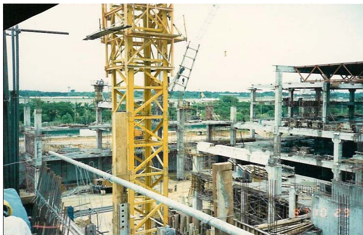
吊装15米预铸梁
