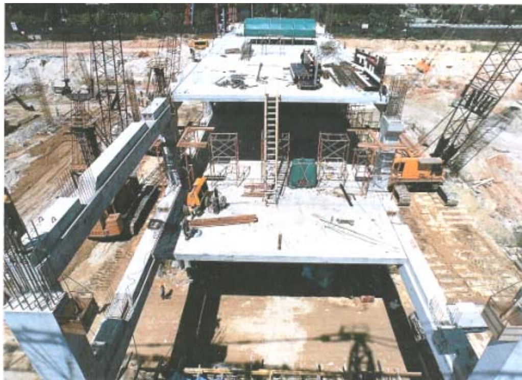
吊装15x15米预铸梁及中空楼板 并配合6米高柱的标准单元
